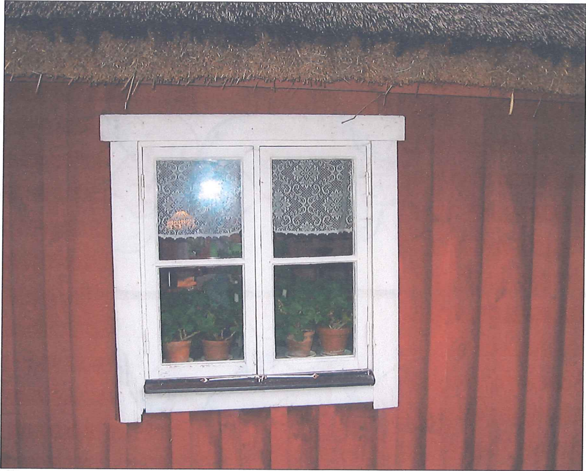
Flitens lampa lyser i Bollaltebyggets vaktmästarebostad och ännu blommar pelargonerna i fönstret, liksom de gjorde då gården "upptäcktes" för drygt 80 år sedan.
