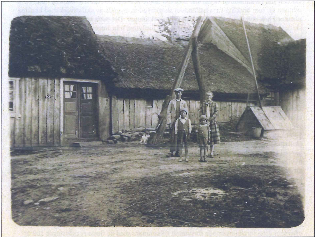
Ryggåsstugan i Jonsnahult före flytten till Bollaltebygget 1937.
